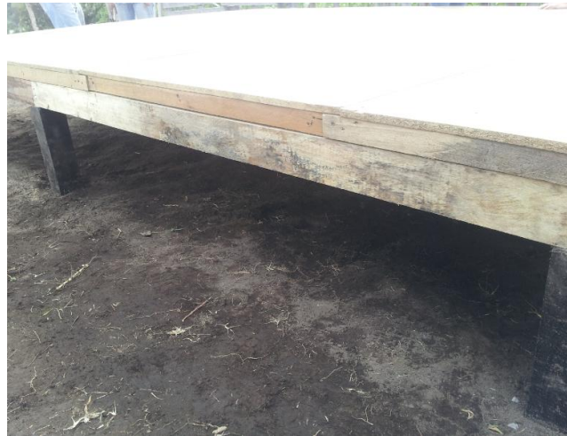
Figura 1: Estructura de piso
