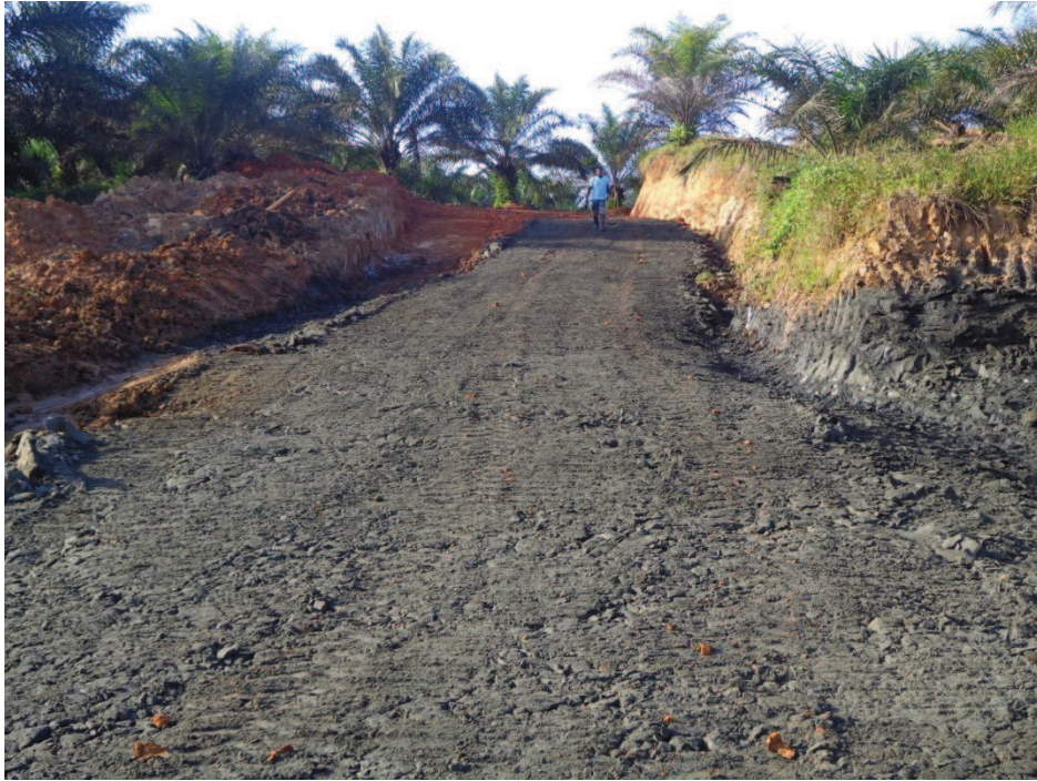
Ilustración 11: Camino Principal de la Hacienda Después De El Mantenimiento. Diciembre 2013
