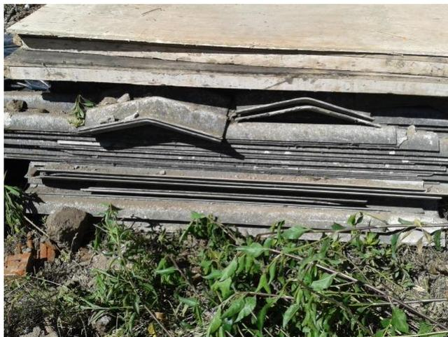
Fotografía N° 4.3.9: Planchas de asbesto – cemento retiradas de la vivienda a demoler
