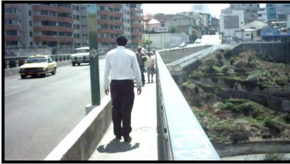
PEQUEÑA CALZADA EN EL ACTUAL PUENTE
