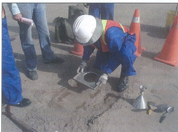
Figura 3.3.- Nivelación del terreno.
