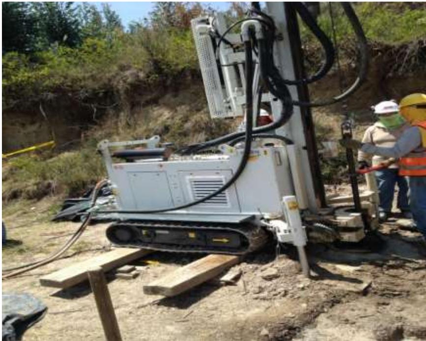
Figura 29, Maquina de perforaciones y ensayo SPT
