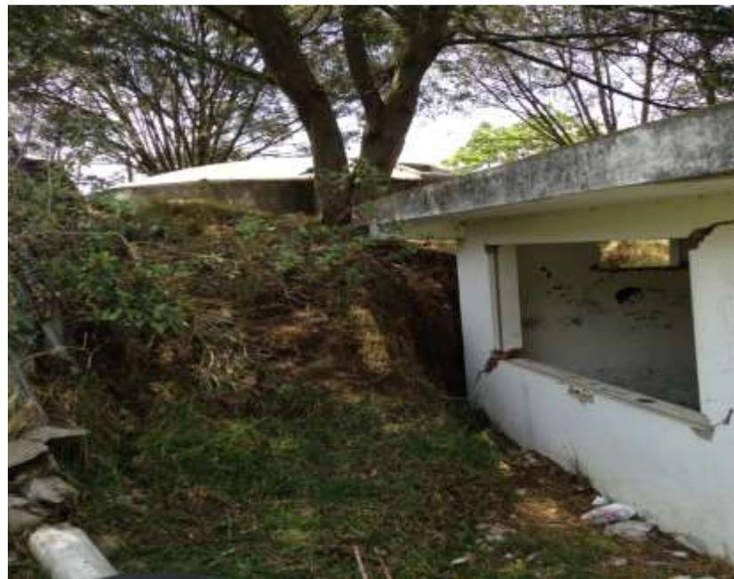
Figura 27, Daños por deslizamientos aledaños.
