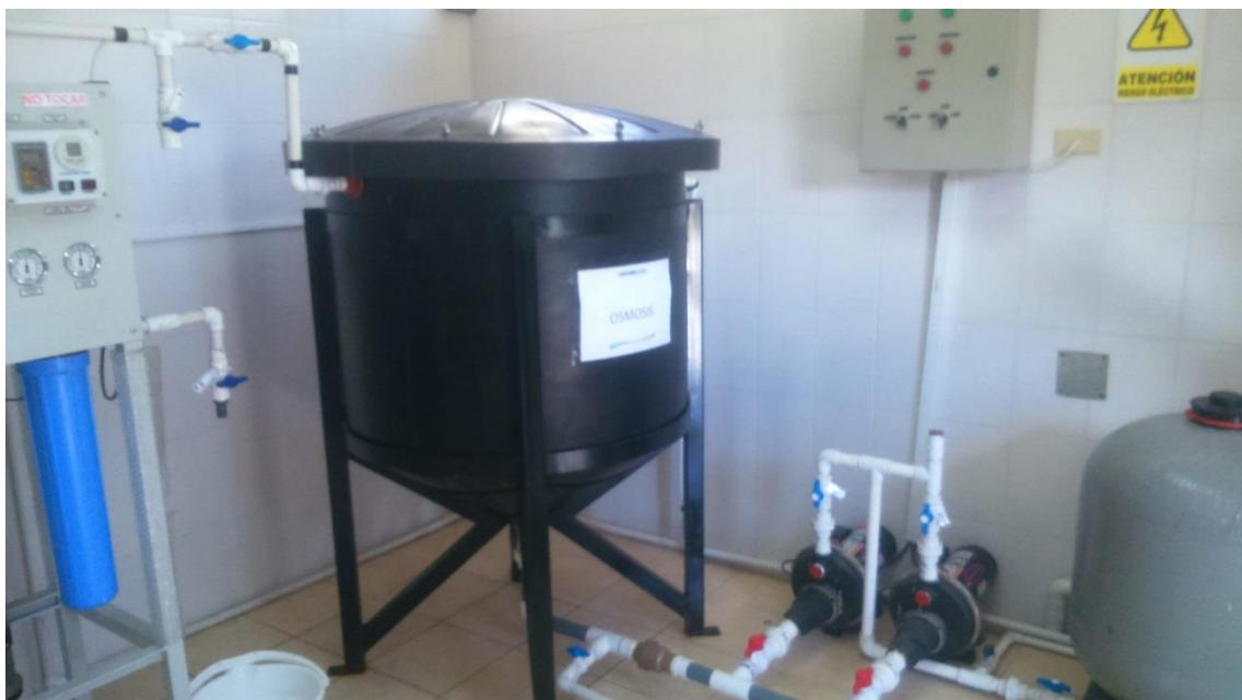
*Figura 4.8: Tanque de almacenamiento final para distribución del agua en el Centro de Diálisis*
