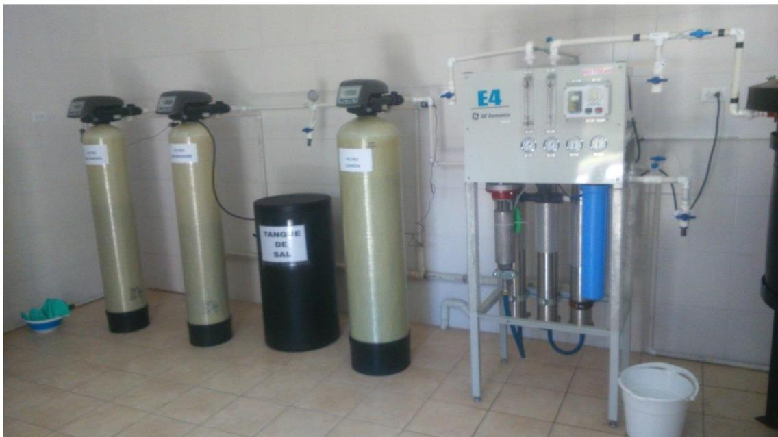
*Figura 4.7: Distribución de la planta de tratamiento de aguas en el Hospital de los Valles*
