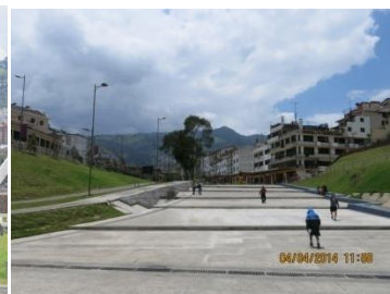
F. 4.3.- Piso Duro, caminerías
