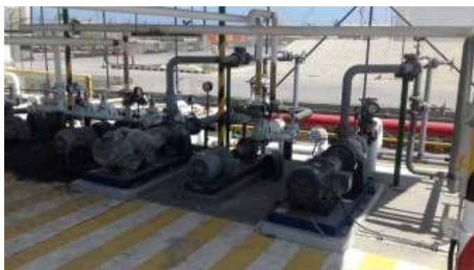
Figura 15. Bombas horizontales de transporte de gasolina extra, bomba 6x4x19.
