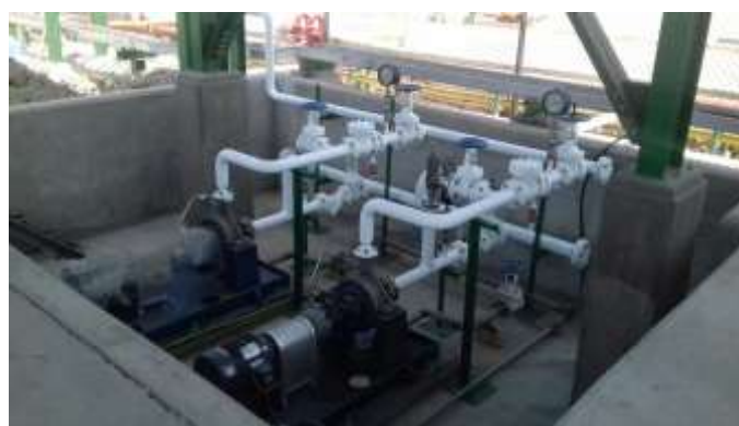
Figura 14 Bombas horizontales de transporte de etanol, bomba 3x1,5x9,5.
