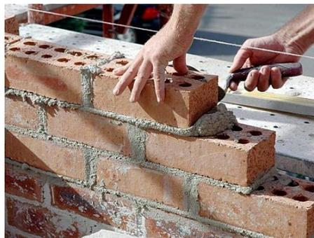
**Figura 1.** Aparejo trabado de unidades colocados a soga para mampostería estructural.
