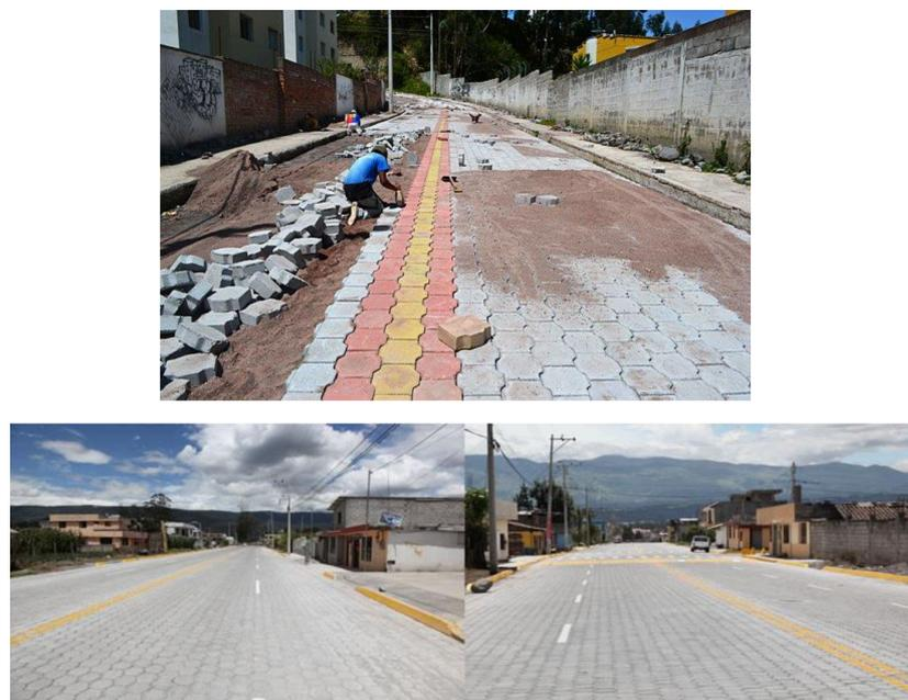
Figura 14. Pavimento articulado. Clase de diseño de pavimentos por Gustavo Boada(2017).
