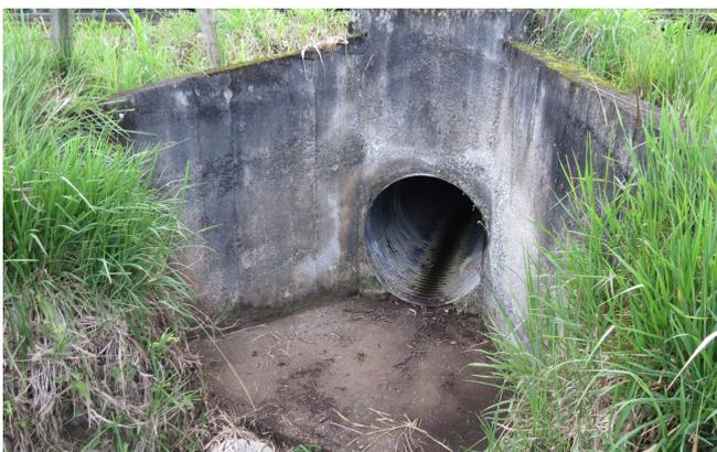
*Fotografía 11. Alcantarillas con cabezal*
