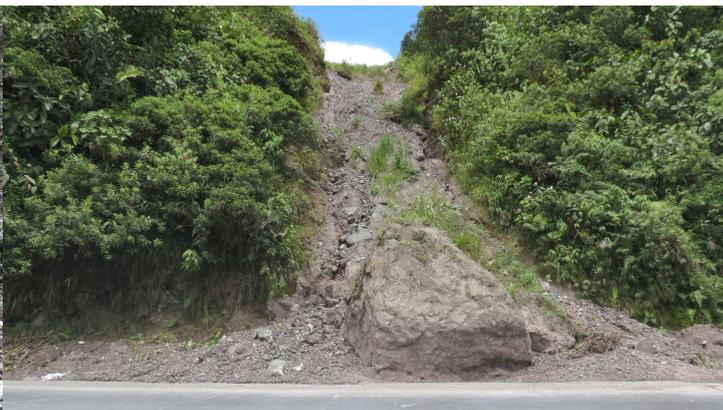
*Fotografía 24. Punto crítico- deslizamiento*
