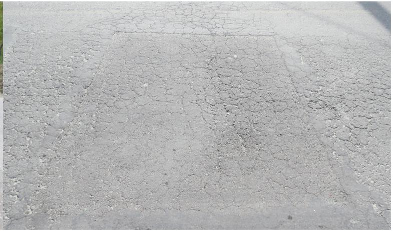
*Fotografía 29. Desprendimiento de agregados      Fotografía 30. Piel de cocodrilo y parcheo*
