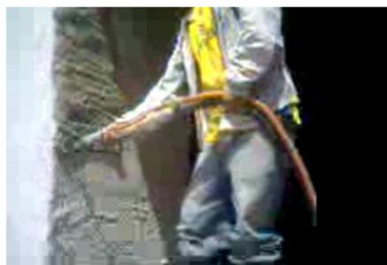
*Imagen4.1.3.1c* "Colocación mortero seco en máquina" *Imagen4.1.3.1d* "Aplicación del mortero a máquina"
