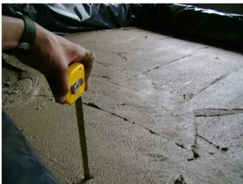
*Imagen 9.2.1b "Medición del espesor del mortero en cubeto"*
