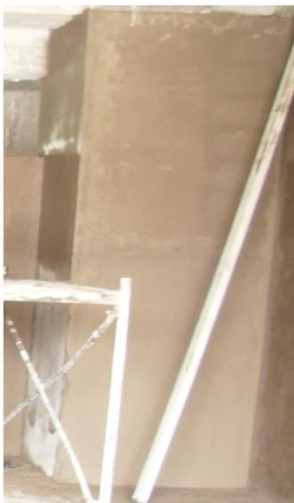
*Imagen 9.2.1g "Acabado final, enlucido de sección estructural: columna"*
