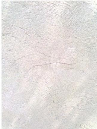
*Imagen9.1.2.4.2c" Fisuras en enlucido con mortero tradicional"*
