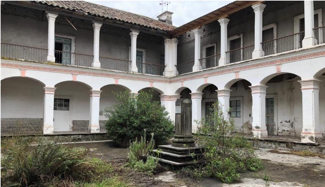
*Figura 7. Fotografía Patio interior central. Se observa materialidad y estado actual.*
