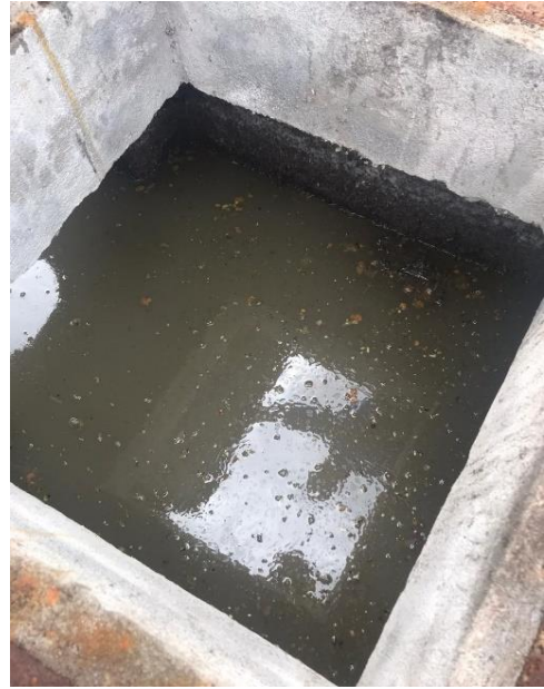
Anexo 8. Tanque repartidor de Caudal
