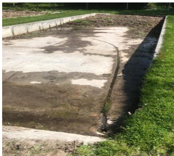
Anexo N. 12 Lechos de Secado
