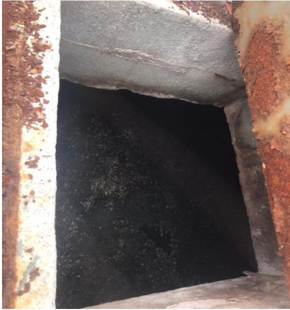
Anexo 7. Tanque repartidor de Caudal
