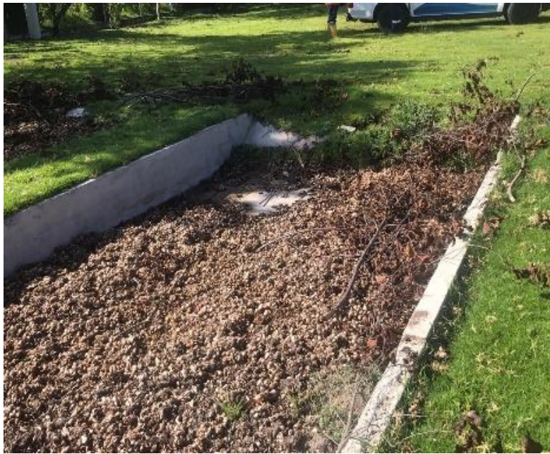
Anexo N. 18 Lechos de secado
