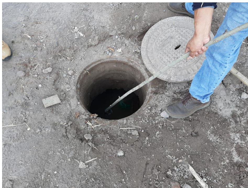
Imagen N. 6 Toma de Muestras Planta de Tratamiento San Pablo
