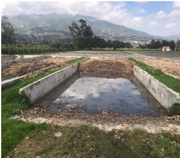
Anexo N.4 Lechos de Secado
