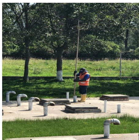
Anexo N. 13 Bombeo Manual
