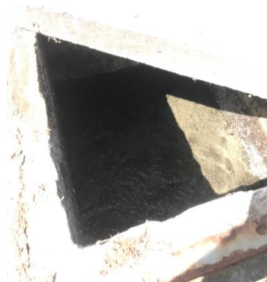
Anexo N. 11 Tanque repartidor de Caudal
