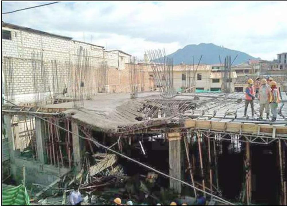
**Figura No. 2** Fallo de encofrado Centro Comercial Paltense ubicado en Loja, Ecuador
