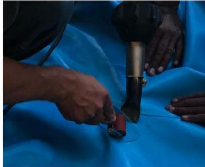
*Gráfico 7: Toma de datos Extrusión del liner*
