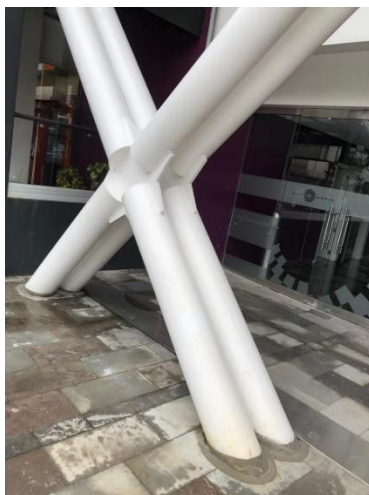
Figura 1: Diagonales Rigidizadoras en la Plataforma Gubernamental Norte – Quito
