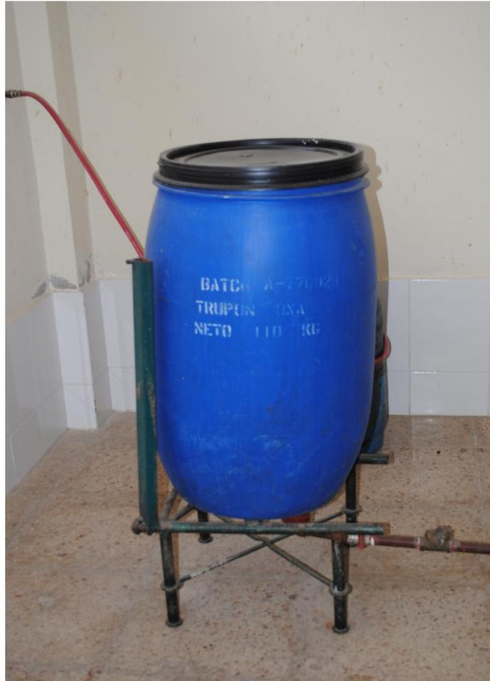
**Figura 3-4:** Tanque de mezcla y alimentación
