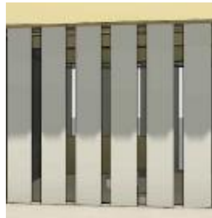
Figura 28: Celosía auditorio. Elaboración propia.
