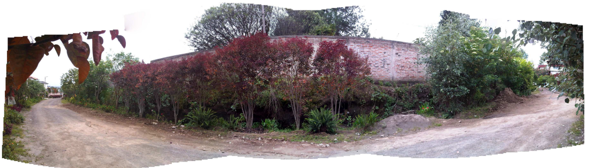
Vista interna desde el Chaquiñan con la fábrica como límite.
