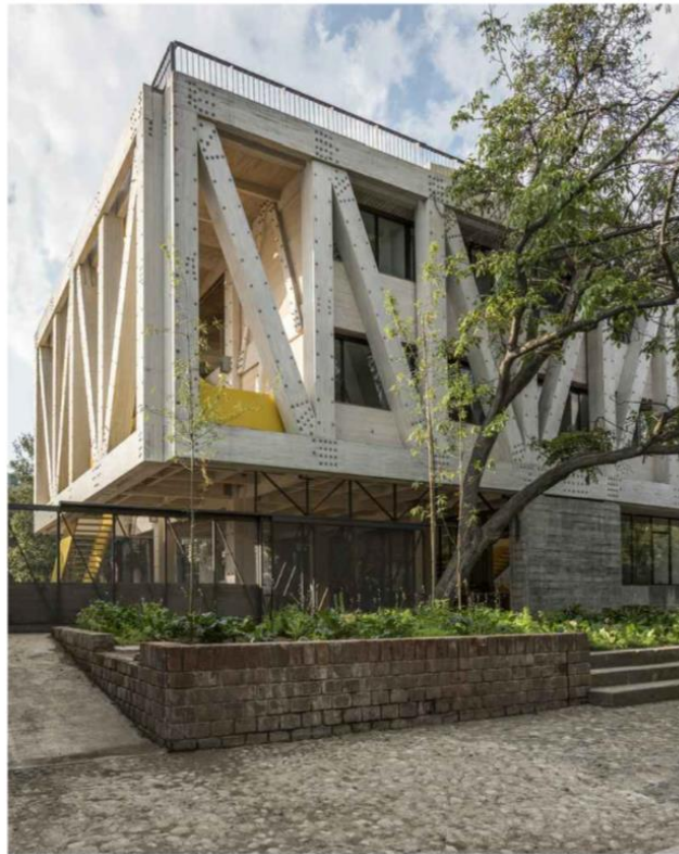
Figura 17: “Escuela de Arquitectura de la Universidad Católica de Chile “Recuperado:
