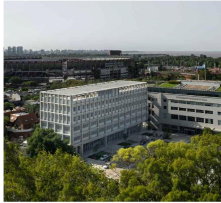
Figura 13: “Edificio Sáenz Valiente” Recuperado de https://www.archdaily.com/943569/universidad-torcuato-di-tella-edificio-saenz-valiente-josep-ferrando-architecture
