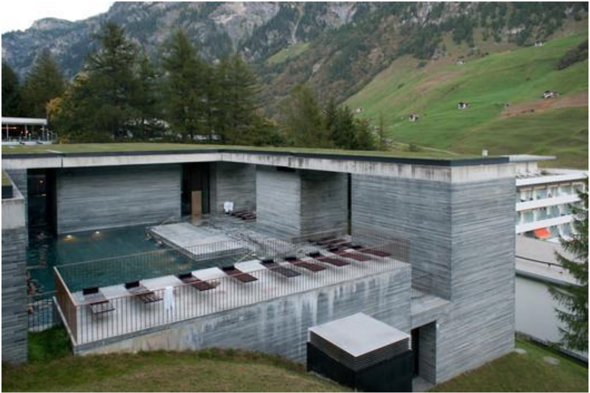
Figura 14. Termas de Vals. Recuperado desde https://www.plataformaarquitectura.cl/cl/765256/termas-de-vals-peter-zumthor
