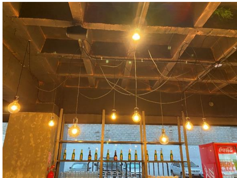
Figura #11. Techo e iluminación.
