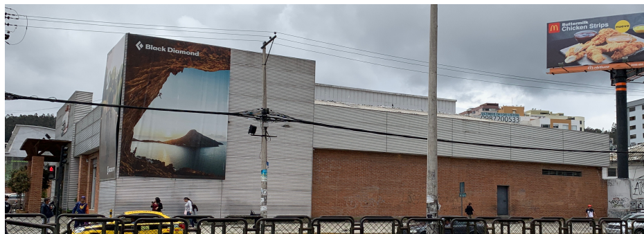
Figura 7. Fachada principal y lateral del establecimiento.
