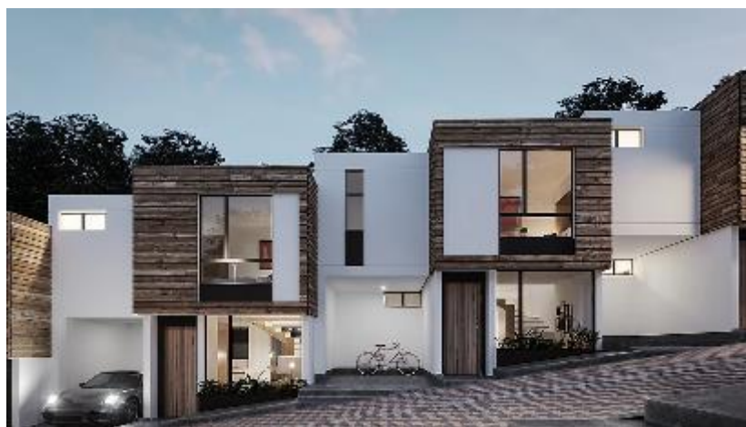
Figura 50: Vista frontal – Portal de Cilicia Fuente: (C&G Constructora, 20202)
