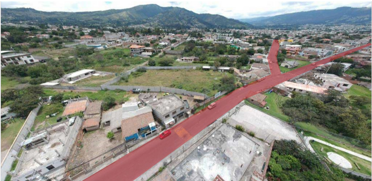
Figura 12: Fotografía vías de acceso al terreno.
