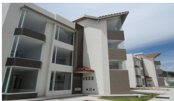
Conjunto habitacional "La Giralda" Departamentos
