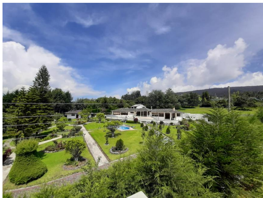
Ilustración 100 Vista posterior desde las viviendas del proyecto
