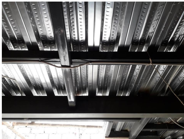
Ilustración 113 Vivienda construida con estructura metálica Fuente: Estudio Marco Jácome
