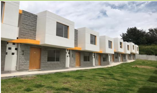
Conjunto habitacional "Lomalinda"
