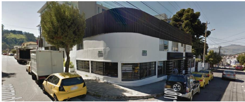
Figura 12 Esquina intersección Guipúzcoa y Lugo
