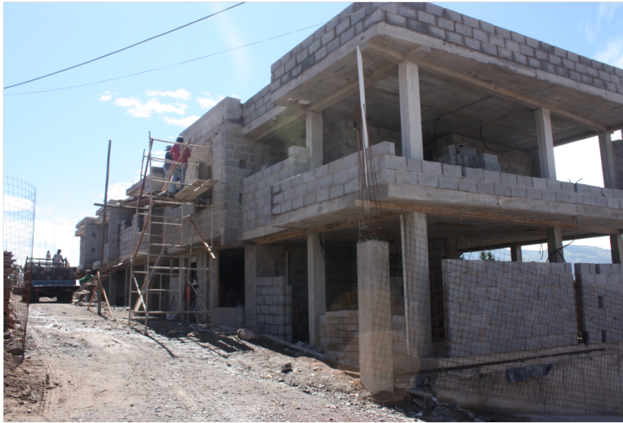
Foto 16 Casa Modelo en Construcción
