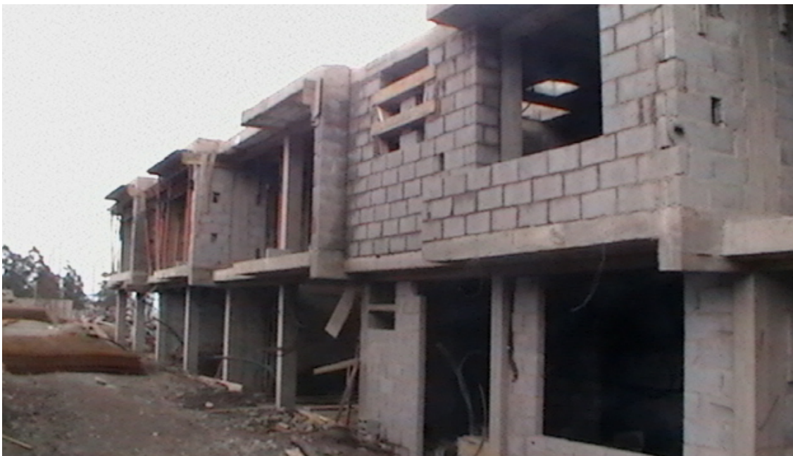
Foto 13 Fase de Construcción
