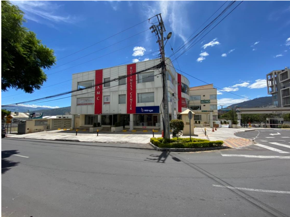
Ilustración 2. Edificio AMC Business Center / Frontal
