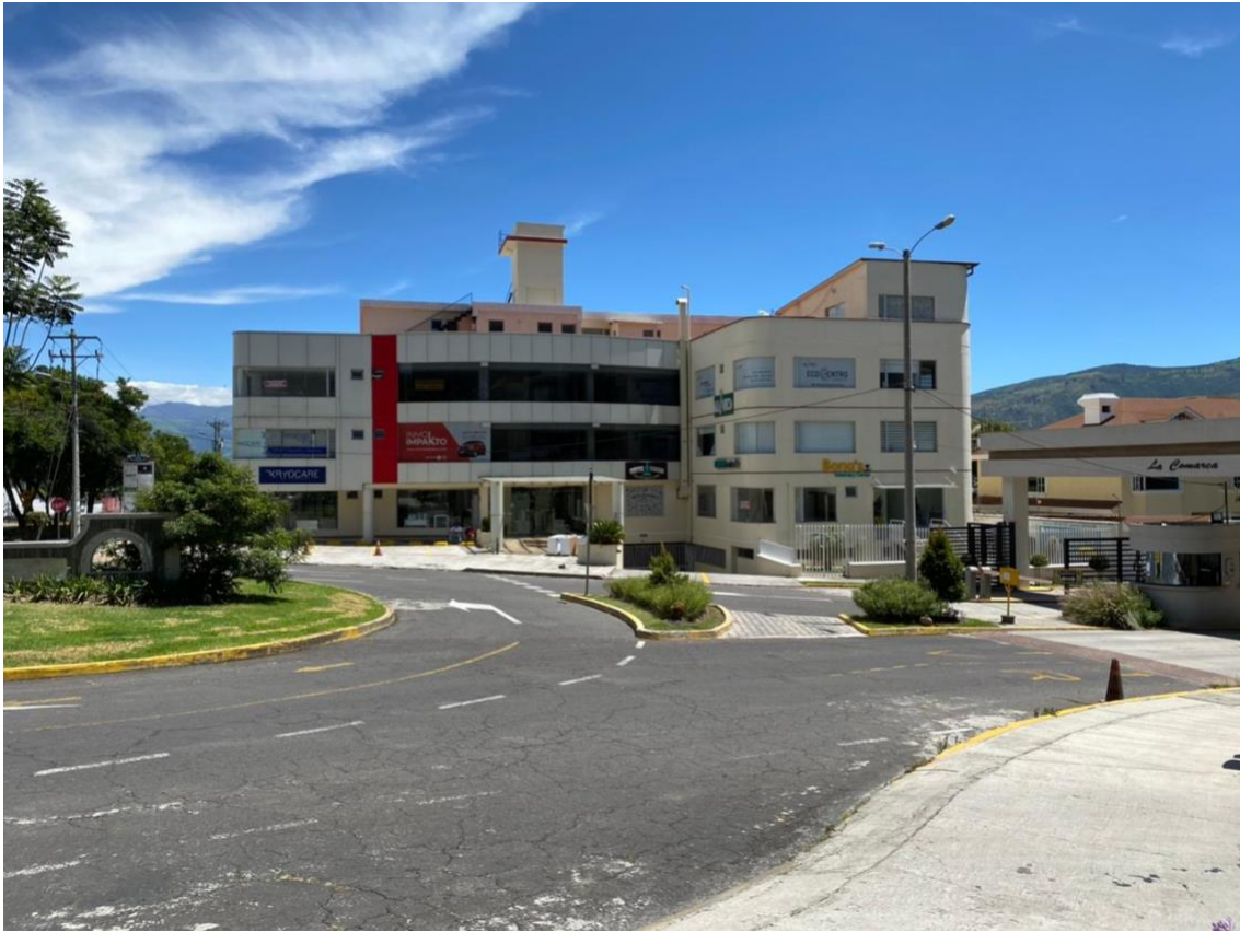
Ilustración 4. Edificio AMC Business Center / Lateral
