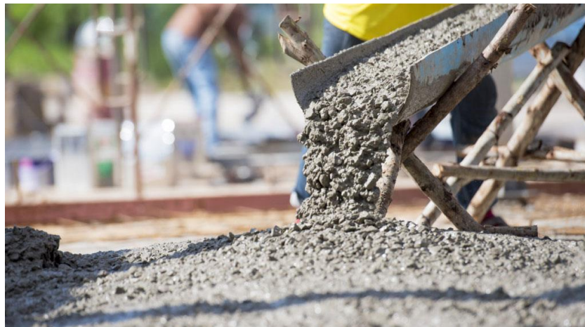
Figura No.3: Hormigón en estado fresco en colocación.
