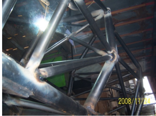
Fig. 2.1.14 Fotografía del proceso de soldadura en la parte frontal del vehículo 97
