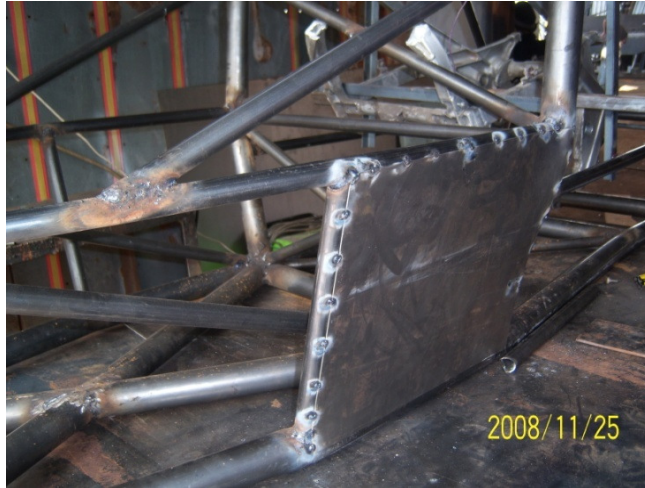
Fig. 2.1.16. Soldadura de la plancha lateral 99
