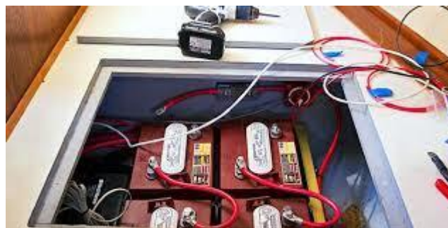
Figura 10: Baterías de auto conectadas en serie (Fondear, 2021)
