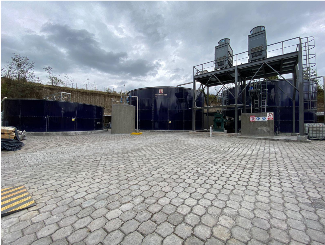
Figura 4. Planta de tratamiento de aguas Indutexma Textiles (Fabrinatore)
