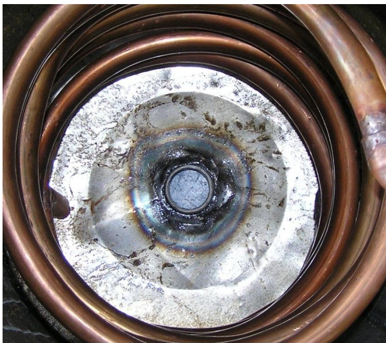
Figura 5.4: Busching en el fondo del tanque para acoplar la resistencia eléctrica
