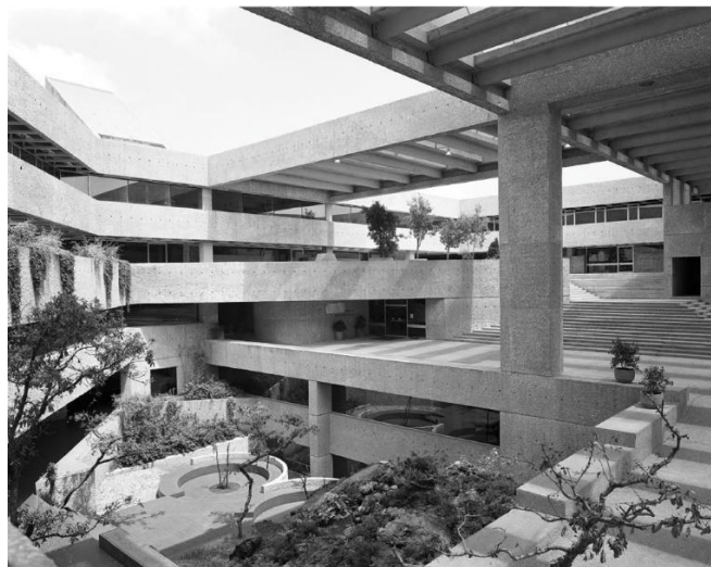
Figura #14. Foto del patio del Colegio de México. Cortesía de ArchDaily
