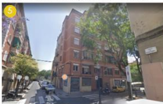
Vista de la fachada frontal del edificio que se encuentra dentro del terreno
