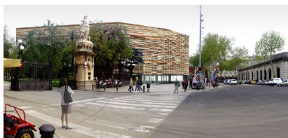
Figura 13. Fachada Polideportivo Parque de la Ciudadela
