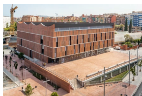
Figura 15. Fachada Polideportivo Camp del Ferro
