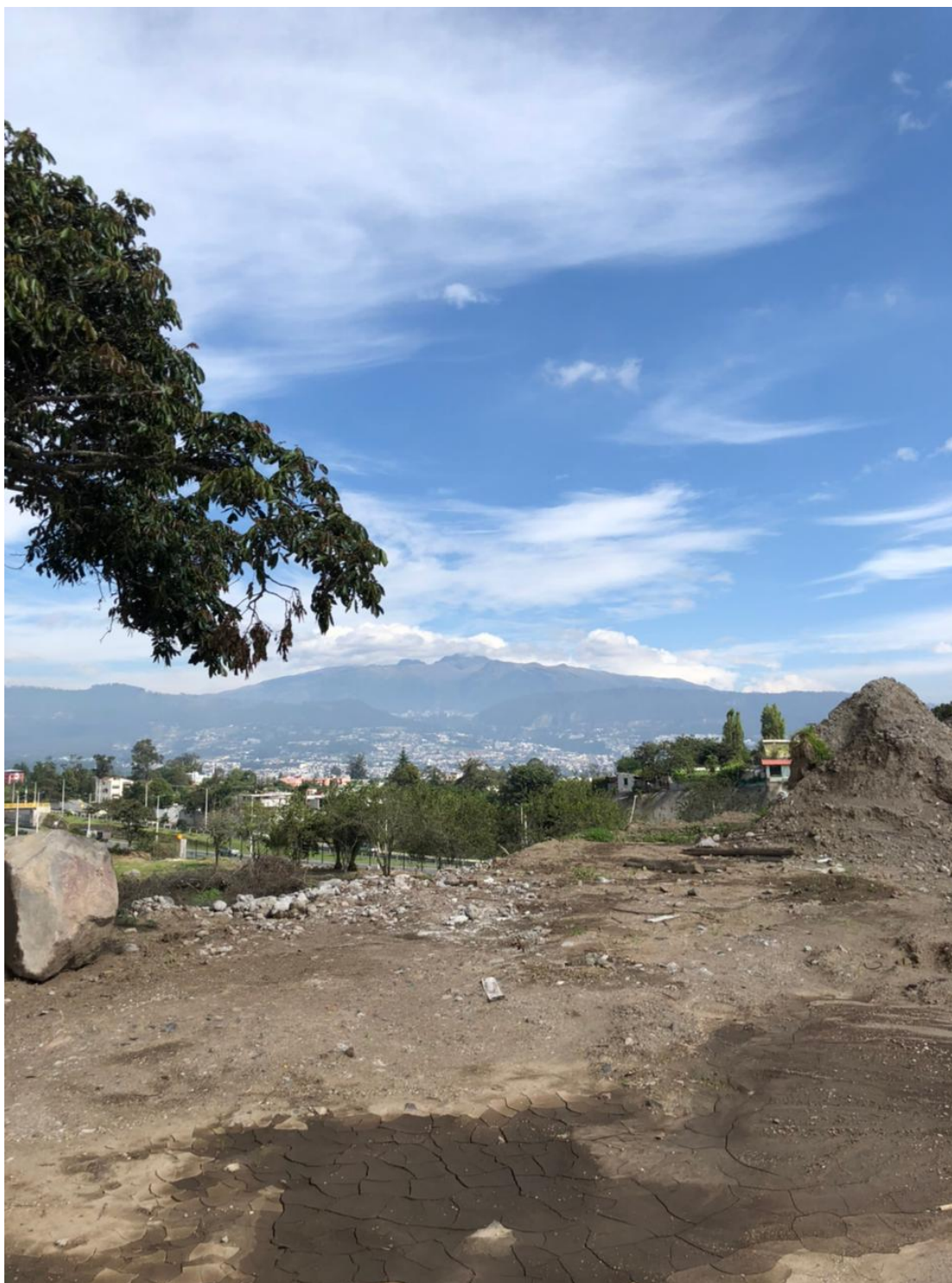
Fuente 95: Construbal y Balarezo Narváz Constructores
