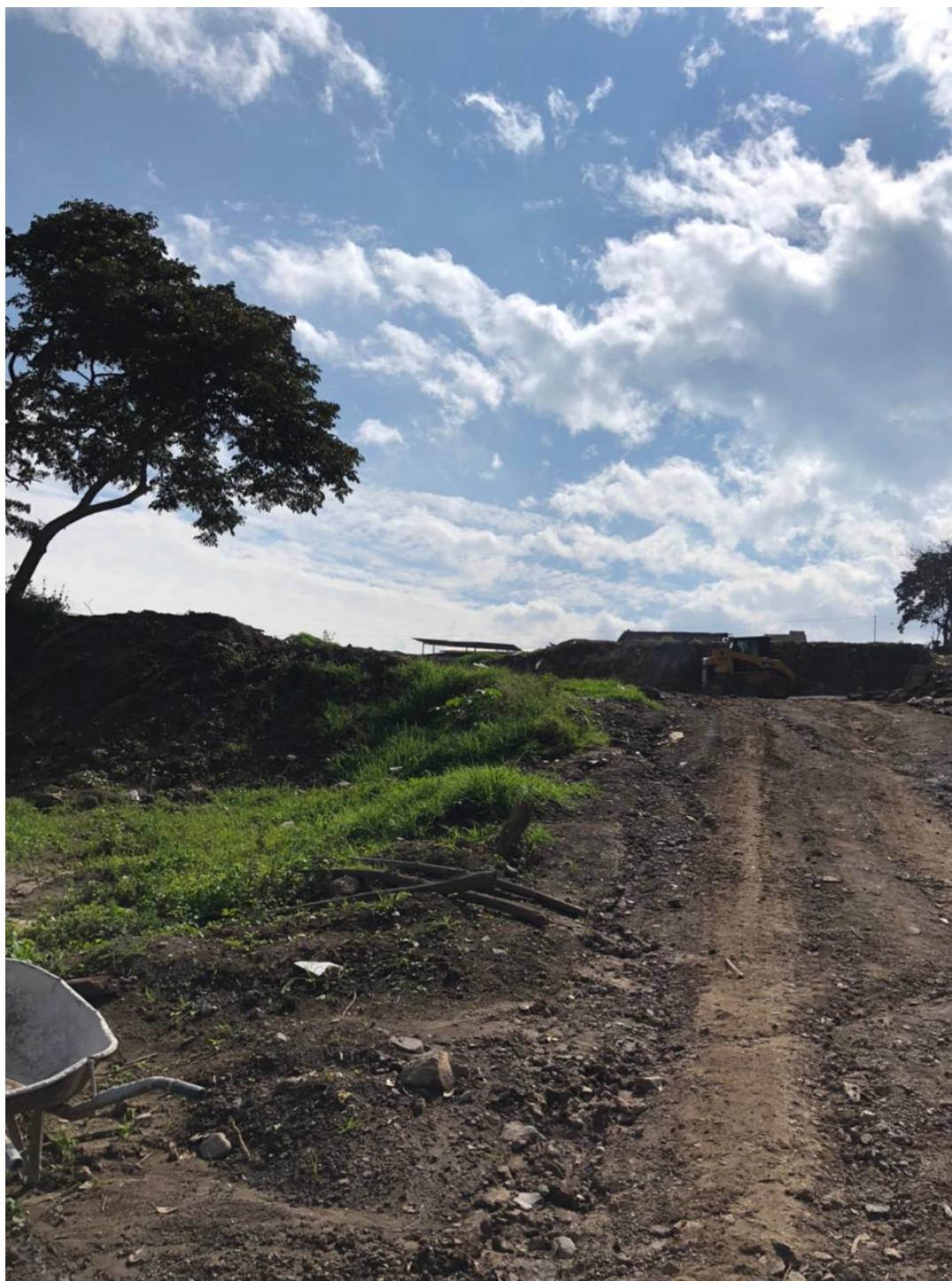
Fuente 96: Construbal y Balarezo Narváz Constructores
