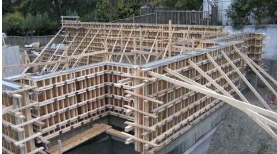
Ilustración 9: Encofrado de madera para muros.
