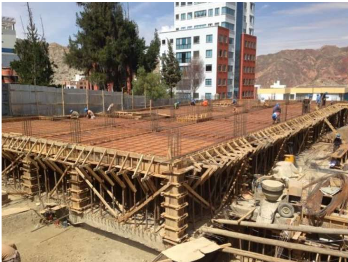
Ilustración 11: Encofrado de madera para losa y vigas.
