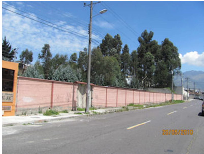
Imagen 10 – Estado Actual del Terreno
