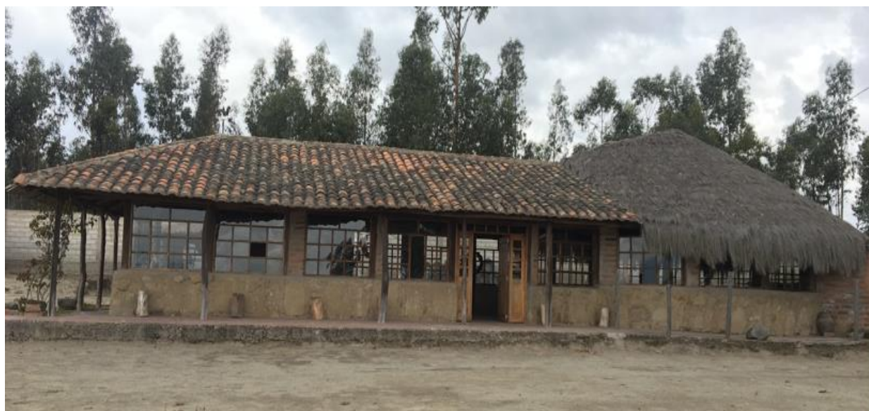
Figura N.-14 Perspectiva general de Hacienda la Luciana y salón de eventos Fuente: El Autor
