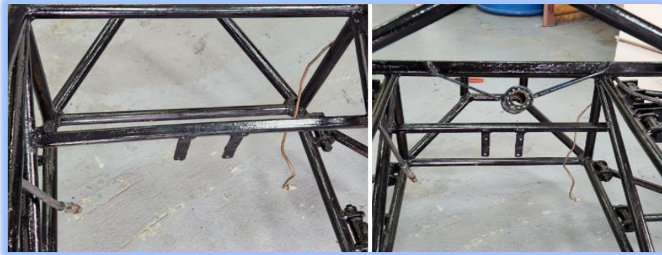
Figura 42. Prueba de seguridad – Inspección de elementos soldados en el chasis (USFQ, 2022)
