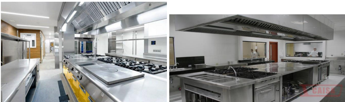
Ilustración 68. ejemplo de cocina industrial. Fuente: SERHS Project y Lacaisa.
