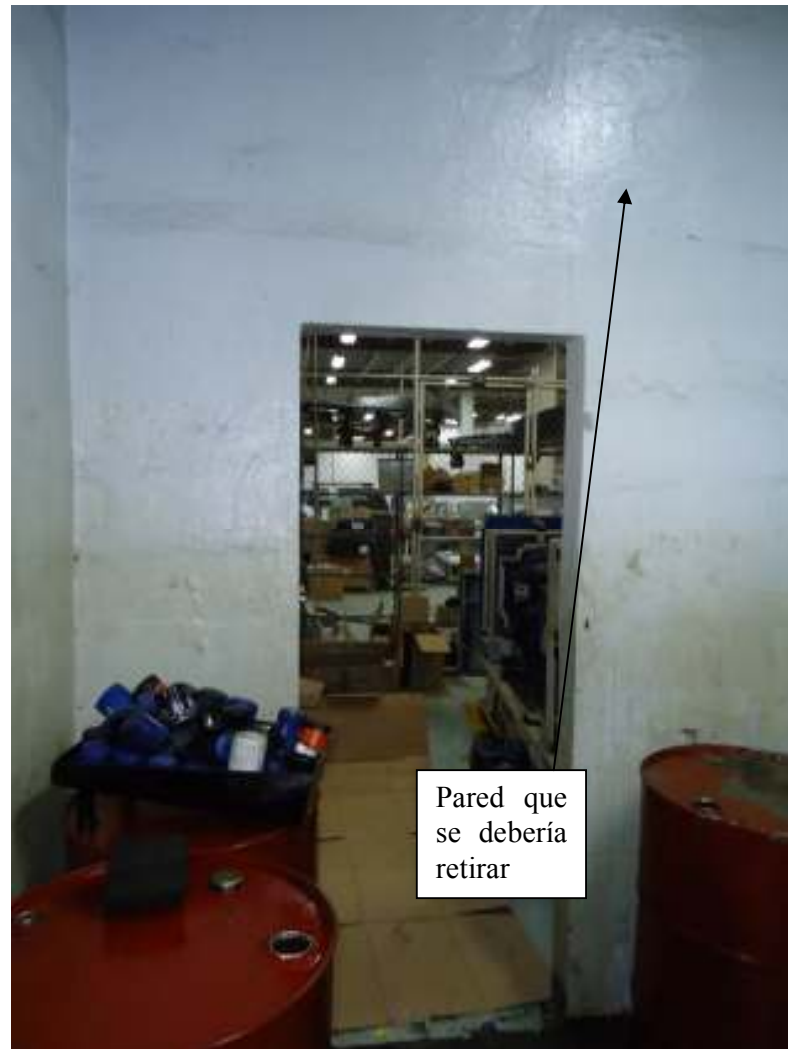
Fotografía 7-1: Pared que divide Zona de Máquinas y Zona Aceite Quemado
