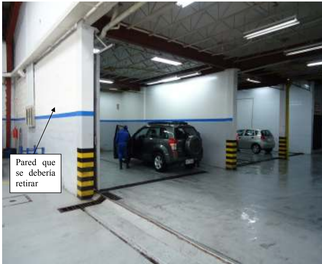
Fotografía 7-3 Pared que divide la parte del Taller con la Zona de Secado
