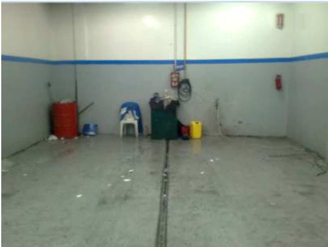
Fotografía 5-3: Evidencia de falta de limpieza
