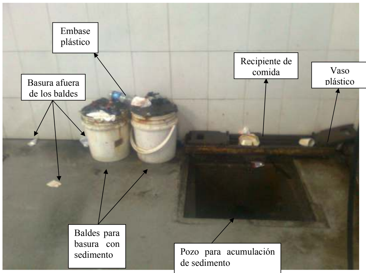
Fotografía 6-2: Baldes de basura y pozo para sedimentos
