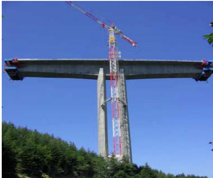
Imagen 2.2.1. Foto de la construcción de un puente en volados sucesivos (Vion y Bouchon).
