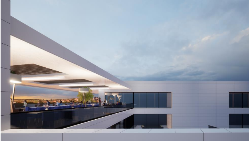
Figura 79. Vista exterior del rooftop. Elaboración propia.
