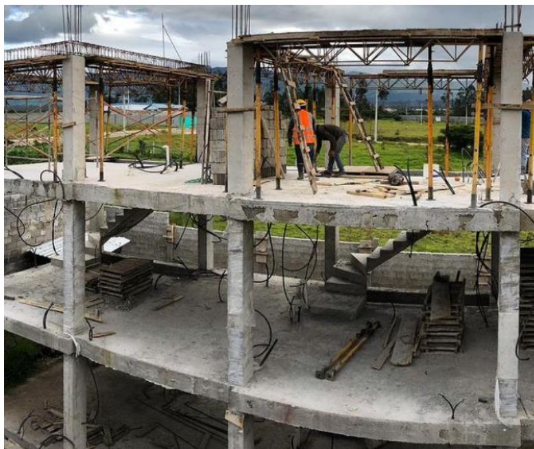
Ilustración 4:28: construcción 3r nivel de Estructura
