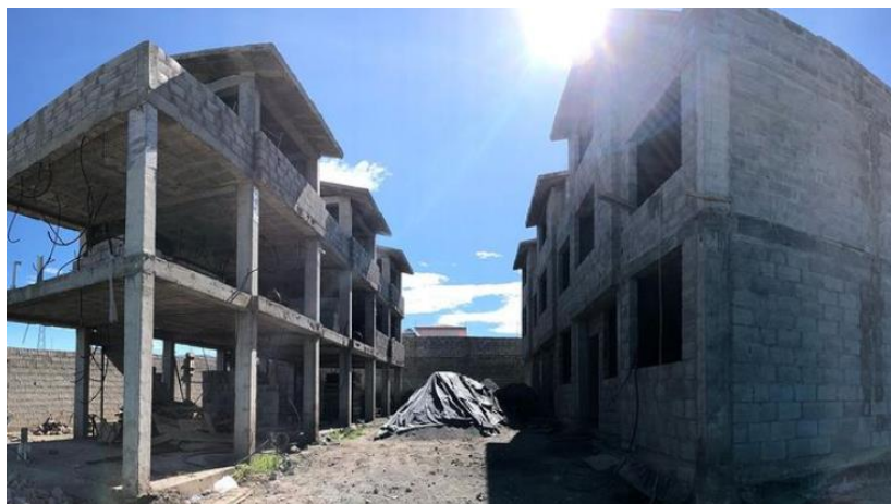
Ilustración 4:29: Sistema constructivo Mampostería
