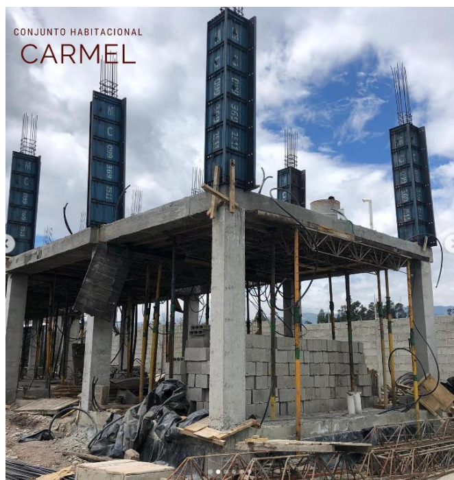
Ilustración 4:26: Formaletas elementos columna
