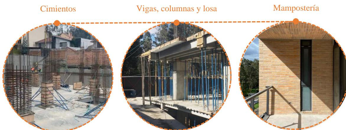
Ilustración 4-64 Sistema constructivo. Fuente: Torres del Bosque. Elaboración: Andres Idrovo.
