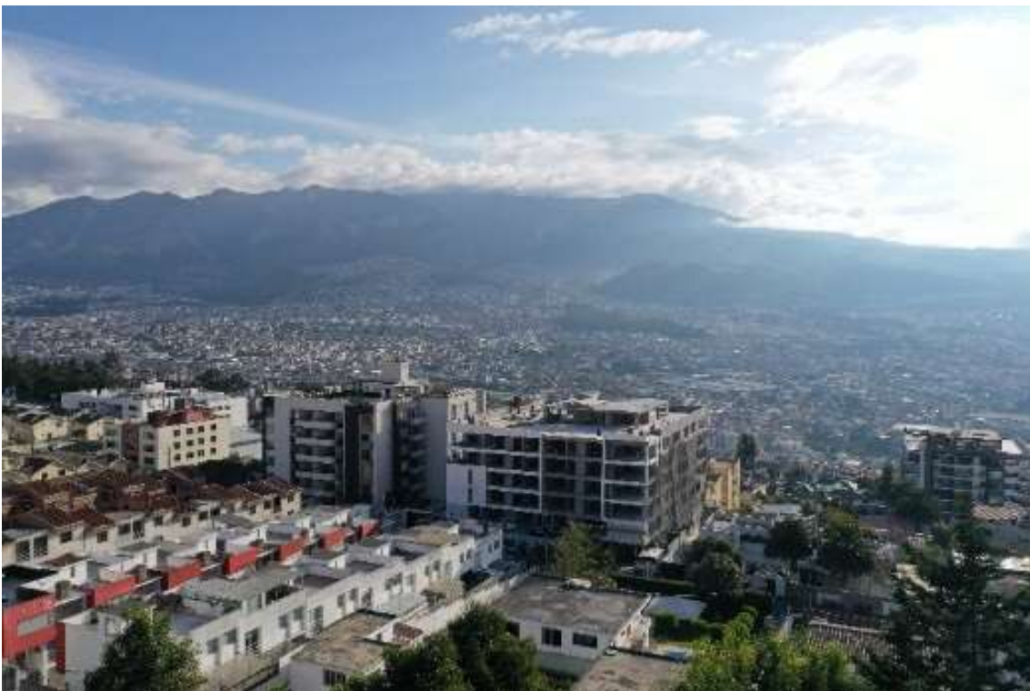
Gráfica 24: Vista frontal edificio "Bilbao"
