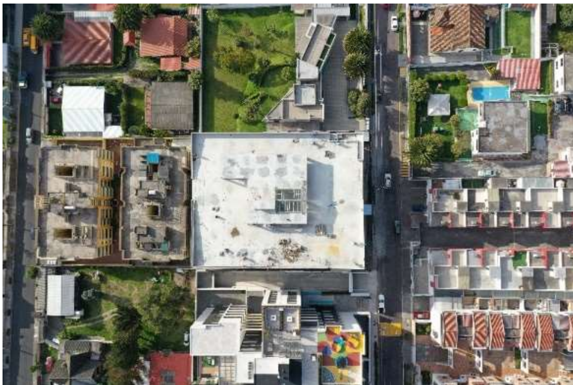
Gráfica 21: Vista superior edificio "Bilbao"
